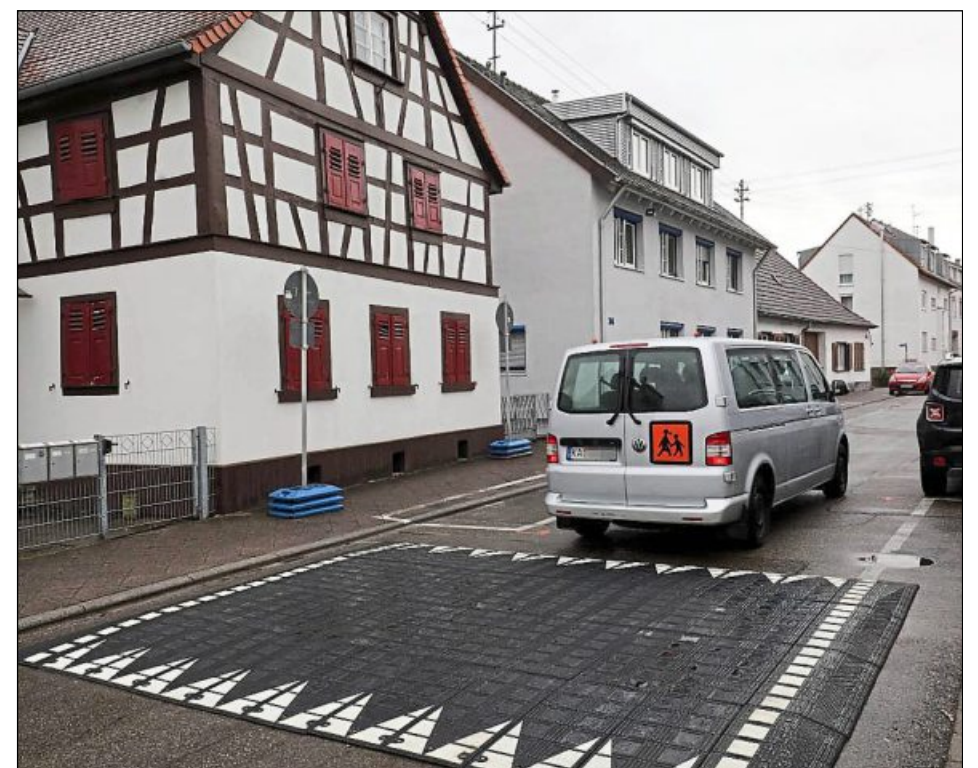
DAS KUNSTSTOFFKISSEN auf der „Untere Straße“ in Knielingen soll die Autofahrer bremsen. Es gehört zum Verkehrsversuch des Reallabors „GO Karlsruhe“. Foto: jodo
